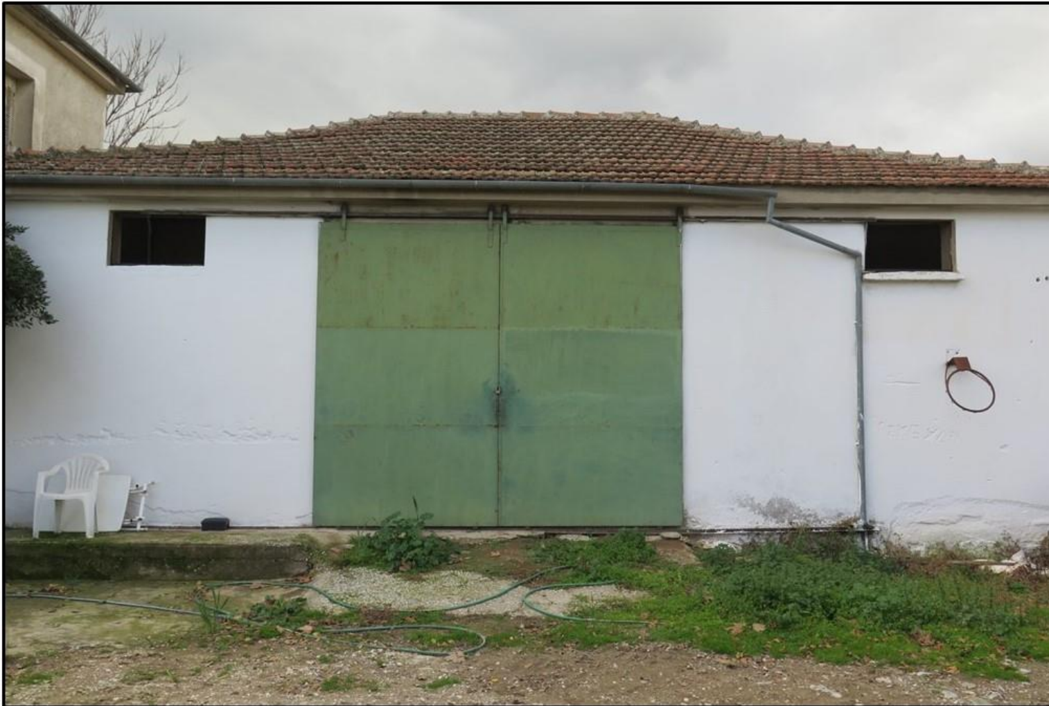
Εικόνα 66. Εξωτερική άποψη αποθηκευτικού χώρου οριζόντιου τύπου συνολικής χωρητικότητας 300 τ.μ. στον οικισμό Πλατυκάμπου του Νομού Λάρισας, που χρησιμοποιεί ο Συνεταιρισμός «ΘΕΣγη» για την αποθήκευση των παραγόμενων προϊόντων.
