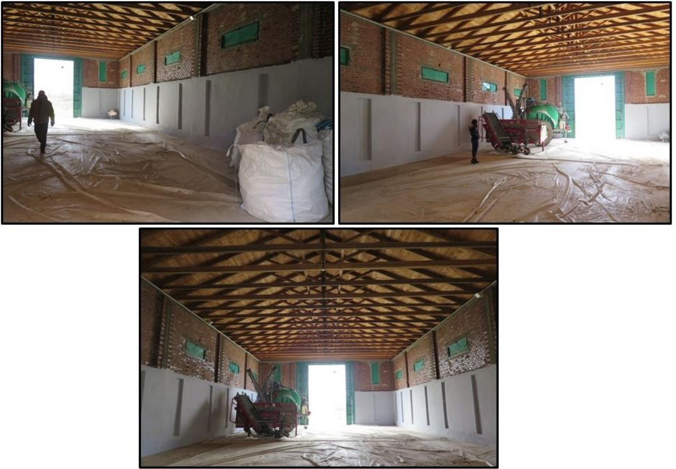
Εικόνα 23. Εσωτερική άποψη αποθηκευτικού χώρου (Αποθήκη Β) στον οικισμό Γυρτώνη του Νομού Λάρισας, που ανήκει στο συγκρότημα αποθηκών οριζόντιου τύπου συνολικής χωρητικότητας 1300 τ.μ., που χρησιμοποιεί ο Συνεταιρισμός «ΘΕΣγη» για την αποθήκευση των παραγόμενων προϊόντων.
