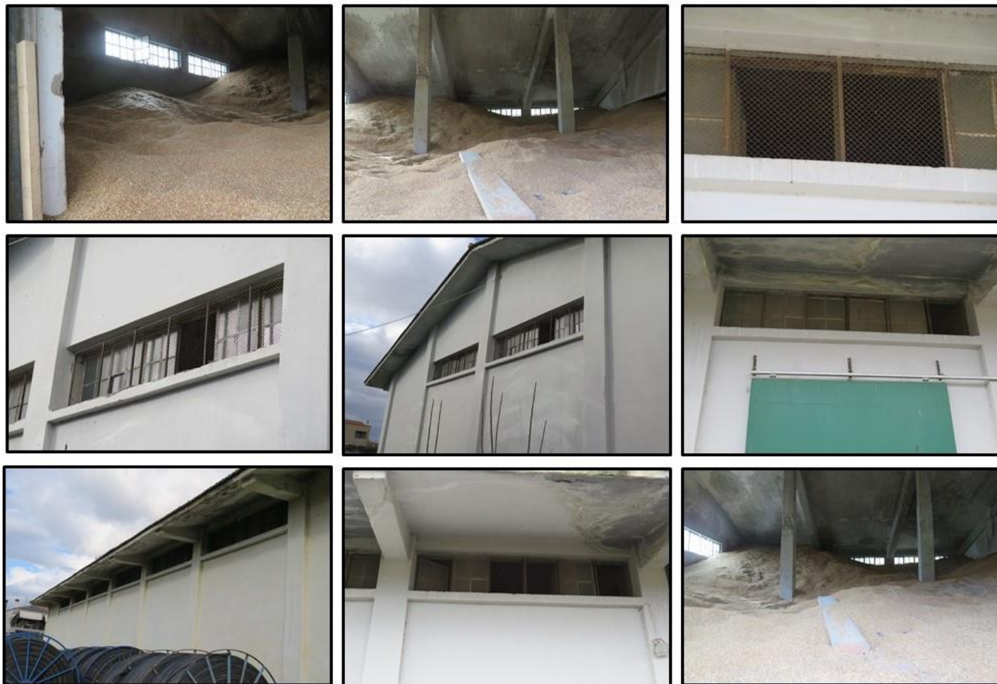
Εικόνα 79. Παράθυρα χωρίς σίτα σε αποθήκη οριζοντίου τύπου του Συνεταιρισμού «ΘΕΣγη», συνολικής χωρητικότητας 460 τ.μ., στον οικισμό Γλαύκη του Νομού Λάρισας, που χρησιμοποιείται για την αποθήκευση γεωργικών προϊόντων.
