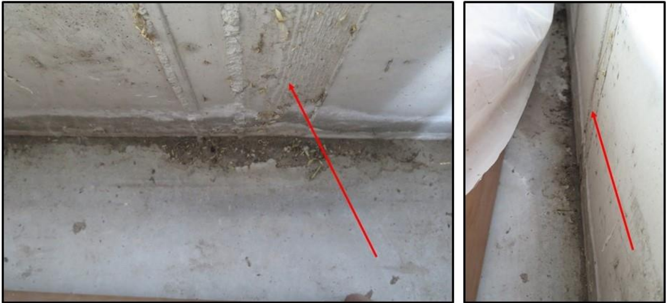
Εικόνα 11. Εσοχές σε διάφορα σημεία σε αποθήκη οριζόντιου τύπου του Συνεταιρισμού «ΘΕΣγη».
