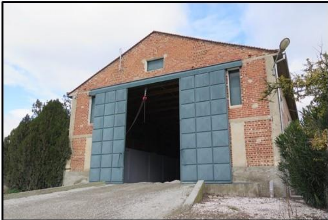
Εικόνα 22. Εξωτερική άποψη αποθηκευτικού χώρου (Αποθήκη Β) στον οικισμό Γυρτώνη του Νομού Λάρισας, που ανήκει στο συγκρότημα αποθηκών οριζόντιου τύπου συνολικής χωρητικότητας 1300 τ.μ., που χρησιμοποιεί ο Συνεταιρισμός «ΘΕΣγη» για την αποθήκευση των παραγόμενων προϊόντων.
