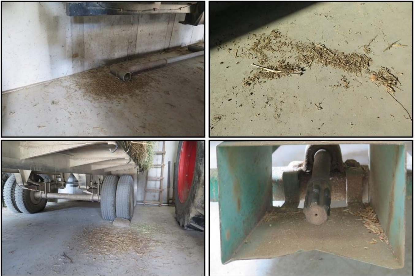
Εικόνα 7. Πλημμελής καθαρισμός – κακές συνθήκες υγιεινής σε αποθήκη οριζόντιου τύπου του Συνεταιρισμού «ΘΕΣγη» στον οικισμό Καστρί του Νομού Λάρισας.
