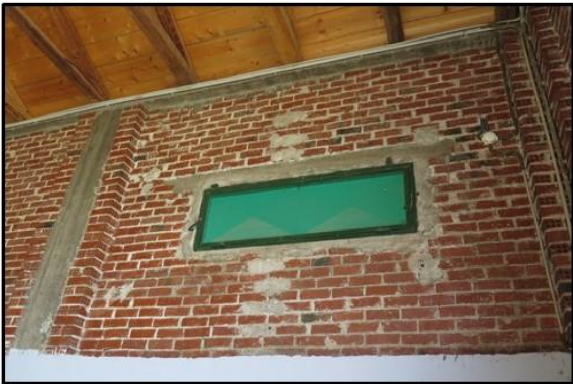
Εικόνα 25. Ανοίγματα (παράθυρα και πόρτα) χωρίς ικανοποιητική προστασία (προστατευτική σίτα, λωριδοκουρτίνες) για την αποτροπή της εισόδου εντόμων σε αποθήκη οριζόντιου τύπου (Αποθήκη Β) του Συνεταιρισμού «ΘΕΣγη» στον οικισμό Γυρτώνη.
