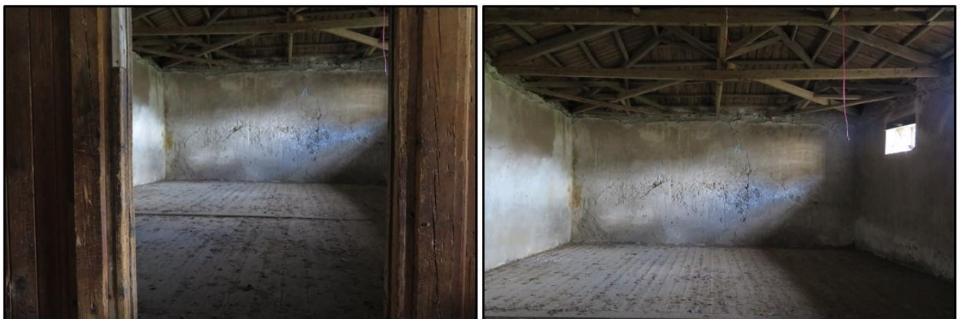
Εικόνα 41. Εσωτερική άποψη αποθηκευτικού χώρου (Αποθήκη ΣΤ) στον οικισμό Γυρτώνη του Νομού Λάρισας, που ανήκει στο συγκρότημα αποθηκών οριζόντιου τύπου συνολικής χωρητικότητας 1300 τ.μ., που χρησιμοποιεί ο Συνεταιρισμός «ΘΕΣγη» για την αποθήκευση των παραγόμενων προϊόντων.
