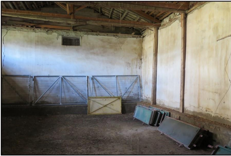
Εικόνα 44. Εσωτερική άποψη αποθηκευτικού χώρου (Αποθήκη Ζ) στον οικισμό Γυρτώνη του Νομού Λάρισας, που ανήκει στο συγκρότημα αποθηκών οριζόντιου τύπου συνολικής χωρητικότητας 1300 τ.μ., που χρησιμοποιεί ο Συνεταιρισμός «ΘΕΣγη» για την αποθήκευση των παραγόμενων προϊόντων.
