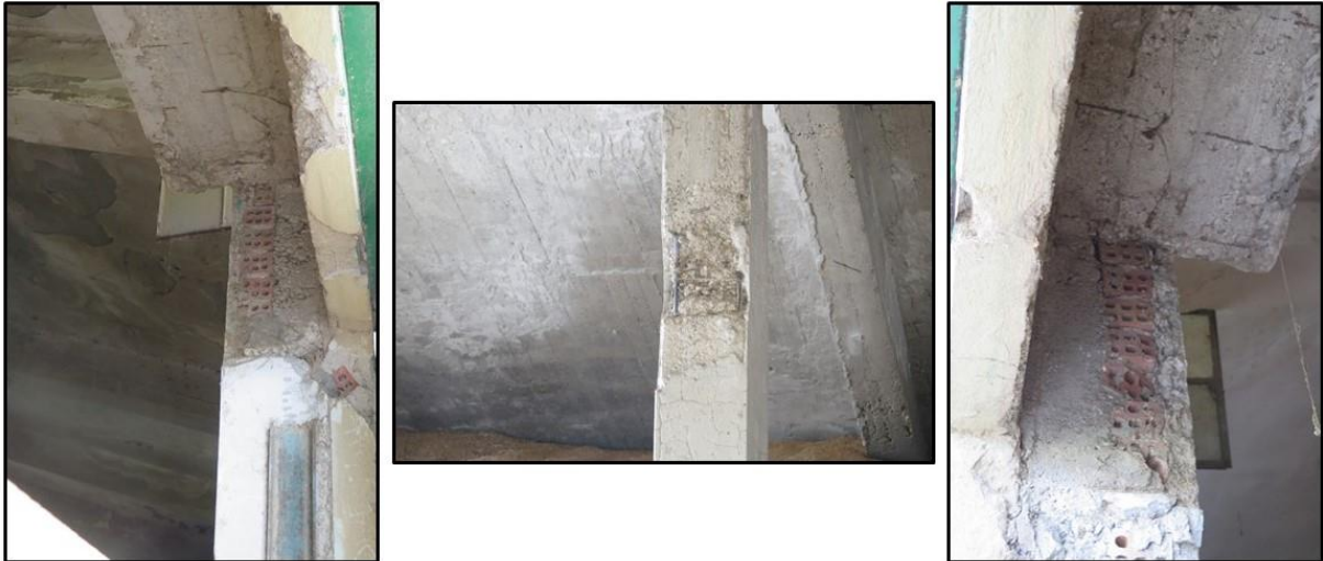
Εικόνα 82. Εσοχές σε διάφορα σημεία σε αποθήκη οριζόντιου τύπου του Συνεταιρισμού «ΘΕΣγη».
