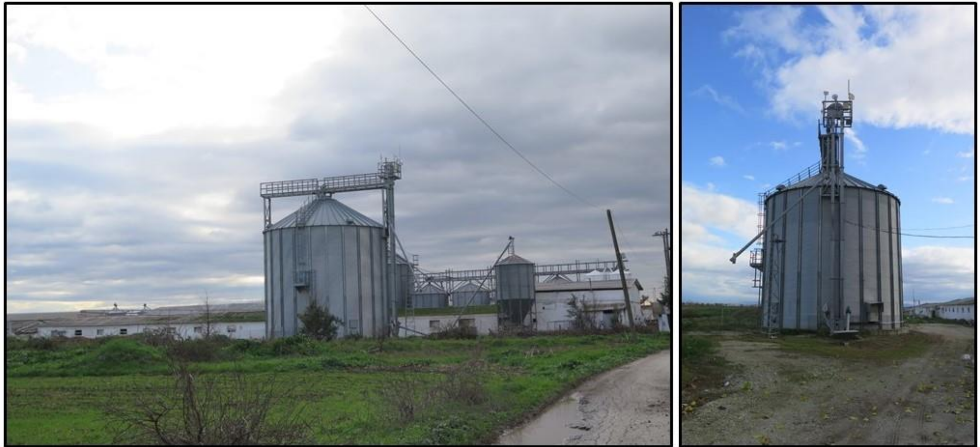
Εικόνα 84. Εξωτερική άποψη αποθηκευτικού σιλό συνολικής χωρητικότητας 1000 τόνων στον οικισμό της Γλαύκης του Νομού Λάρισας, που χρησιμοποιεί ο Συνεταιρισμός «ΘΕΣγη» για την αποθήκευση των παραγόμενων προϊόντων.
