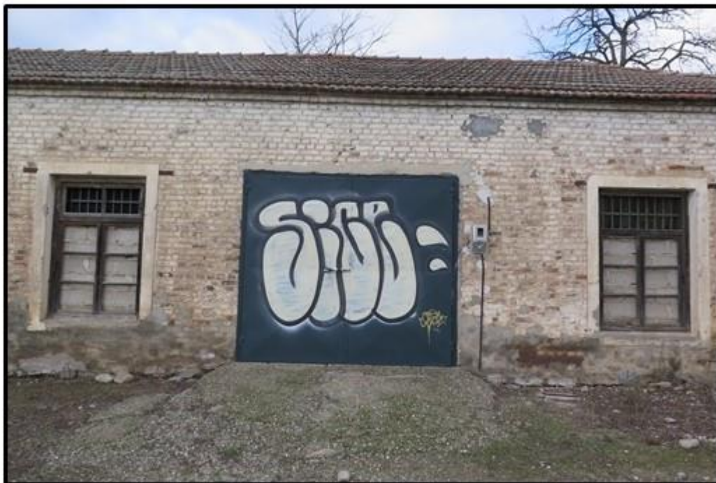
Εικόνα 32. Εξωτερική άποψη αποθηκευτικού χώρου (Αποθήκη Δ) στον οικισμό Γυρτώνη του Νομού Λάρισας, που ανήκει στο συγκρότημα αποθηκών οριζόντιου τύπου συνολικής χωρητικότητας 1300 τ.μ., που χρησιμοποιεί ο Συνεταιρισμός «ΘΕΣγη» για την αποθήκευση των παραγόμενων προϊόντων.
