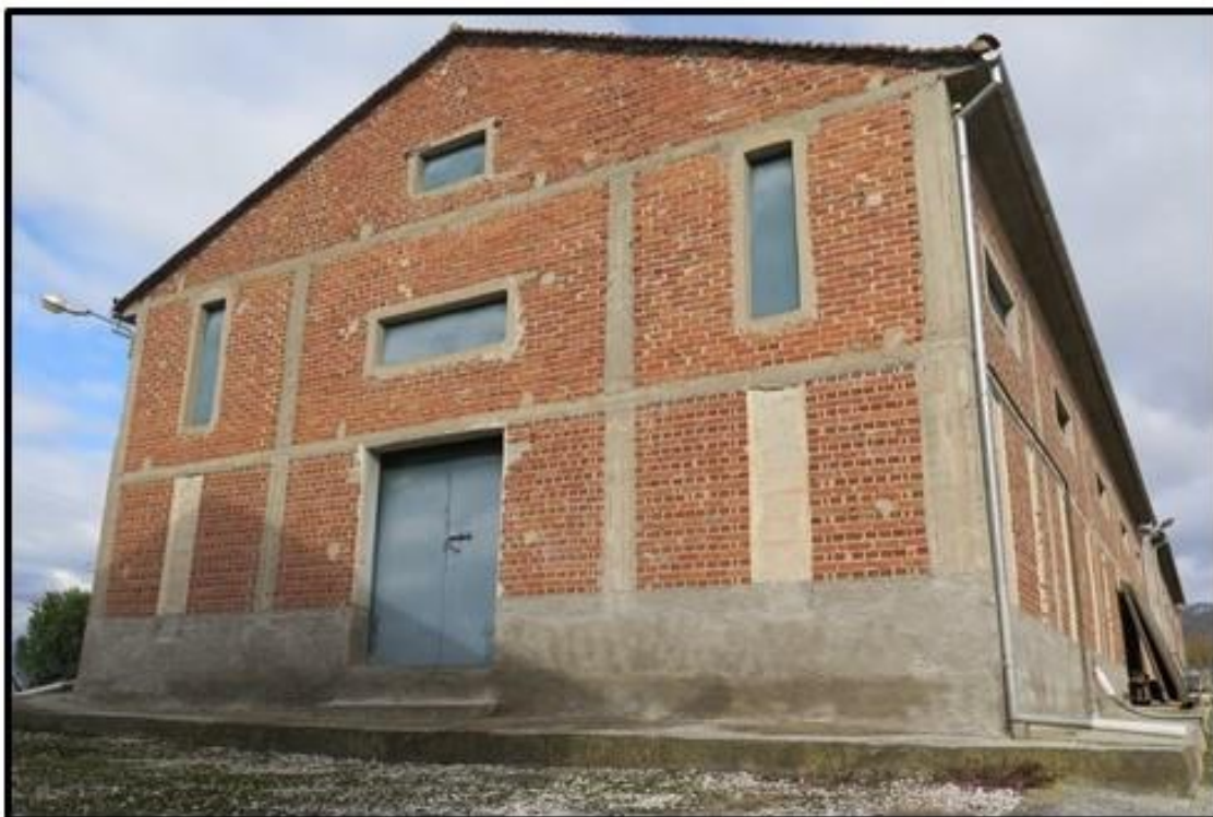
Εικόνα 28. Εξωτερική άποψη αποθηκευτικού χώρου (Αποθήκη Γ) στον οικισμό Γυρτώνη του Νομού Λάρισας, που ανήκει στο συγκρότημα αποθηκών οριζόντιου τύπου συνολικής χωρητικότητας 1300 τ.μ., που χρησιμοποιεί ο Συνεταιρισμός «ΘΕΣγη» για την αποθήκευση των παραγόμενων προϊόντων.
